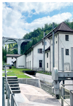
Wasserkraftwerk Lorzentobel bei Zug
